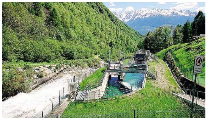
Saranno completati gli impianti irrigui Sponda Soliva
