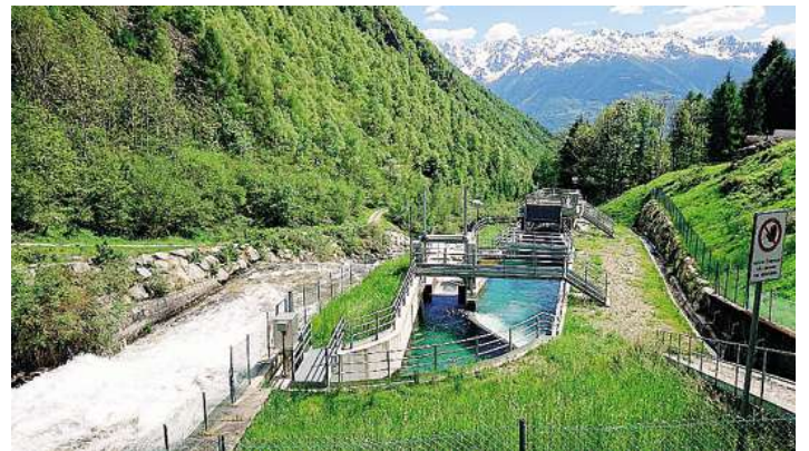
Saranno completati gli impianti irrigui Sponda Soliva
